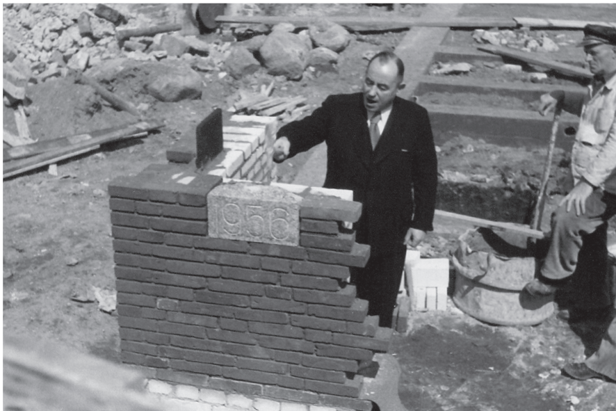
Grundsteinlegung des neuen Gebäudes durch Bischof Wilhelm Halfmann 1956
