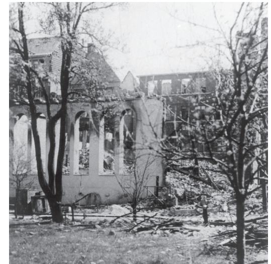
Gebäude des Landeskirchenamtes nach dem Luftangriff am 4. und 5. Januar 1944
