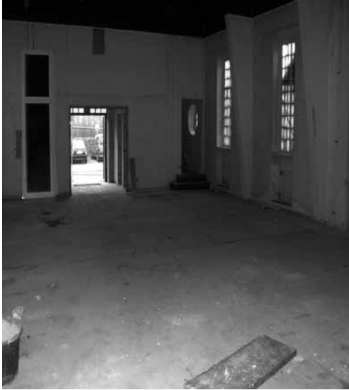
Magazin während des Umbaus
